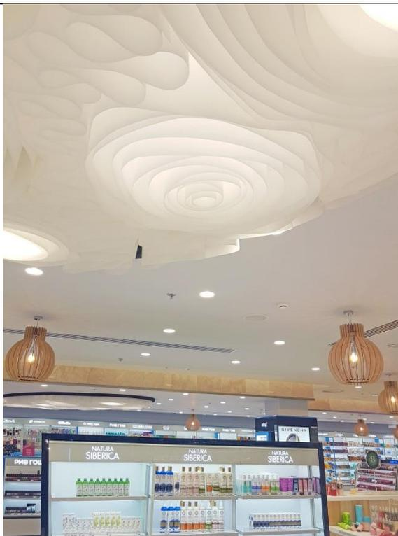
Ламели устанавливаются вручную декораторами, на предварительно установленную оцинкованную сварную сетку, с рекомендованным размером ячейки
