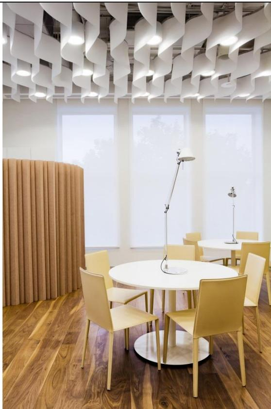
ЛАМЕЛИ из негорючего DropPaper закрепленные на предварительно согнутом алюминиевом профиле высотой 40 см с шагом 25 см
